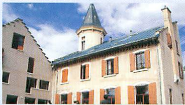
アフラットの校舎全景
